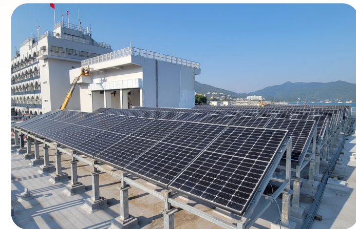
水警東分區基地和水警北分區基地的天台均裝設光伏板。
